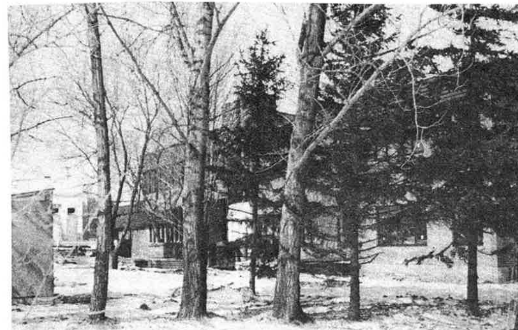
Crkva u izgradnji
